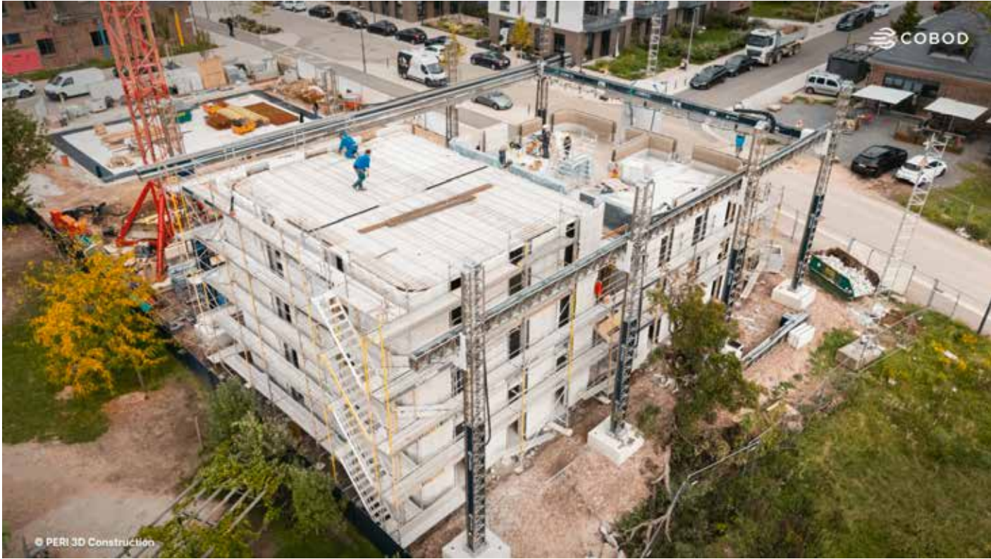
DREIHAUS Large: 348,54 m 2 yaşam alanına sahip, sadece 26 günde tamamlanan 3D baskılı bir bina.
